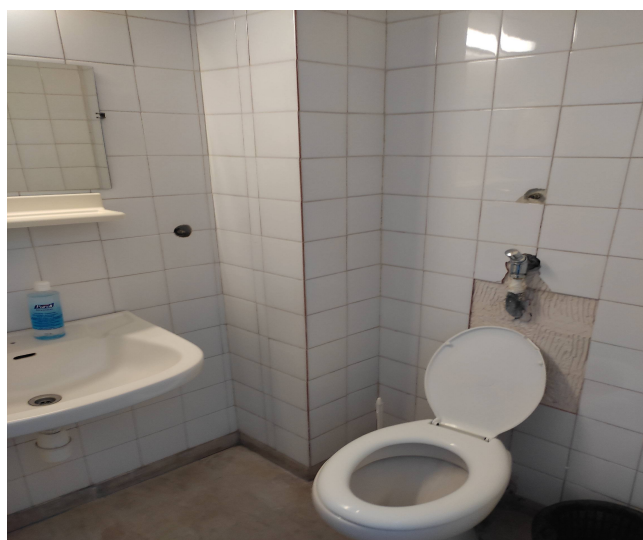
Εικ. 5 Υφιστάμενη κατάσταση WC
