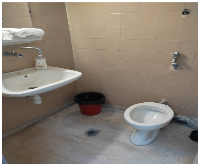
Εικ. 4 Υφιστάμενη κατάσταση WC
