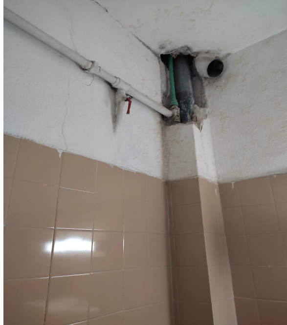
Εικ. 6 Υφιστάμενη κατάσταση WC
